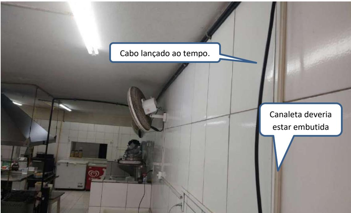
Foto 41: Numa parede da Cozinha, cabos e eletrodutos fixados externamente a parede.
