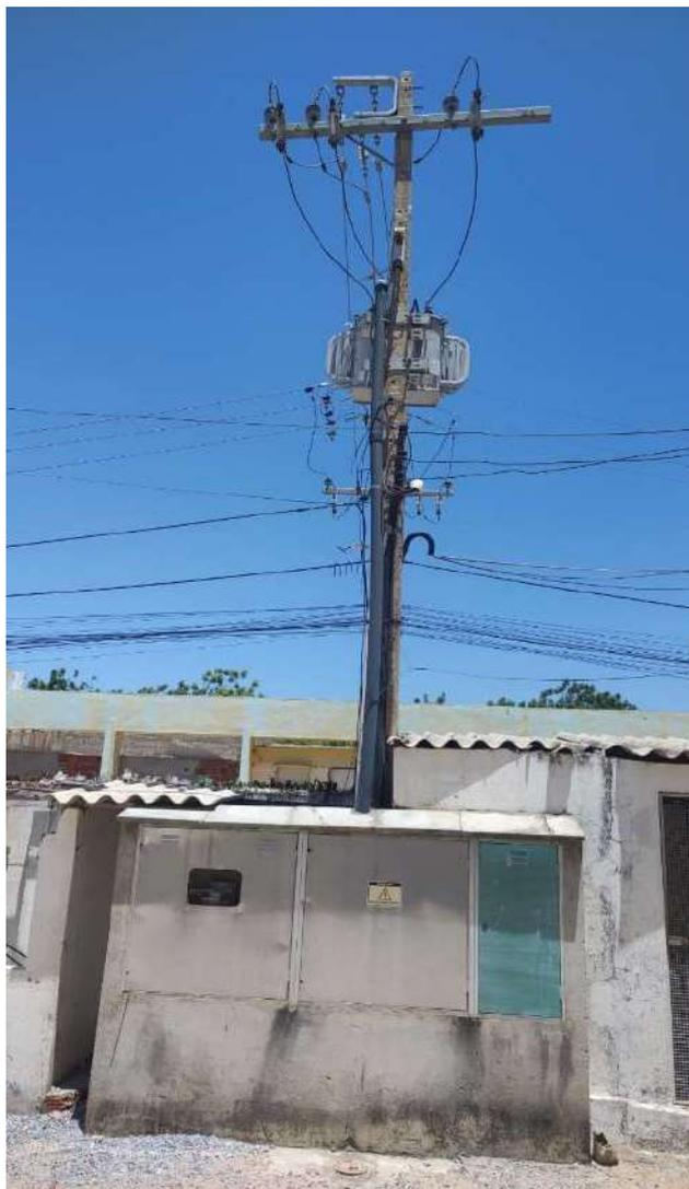
Foto 51 - Subestação de energia elétrica aérea do hotel. Sistema localizado na área térrea, lateral do hotel.
