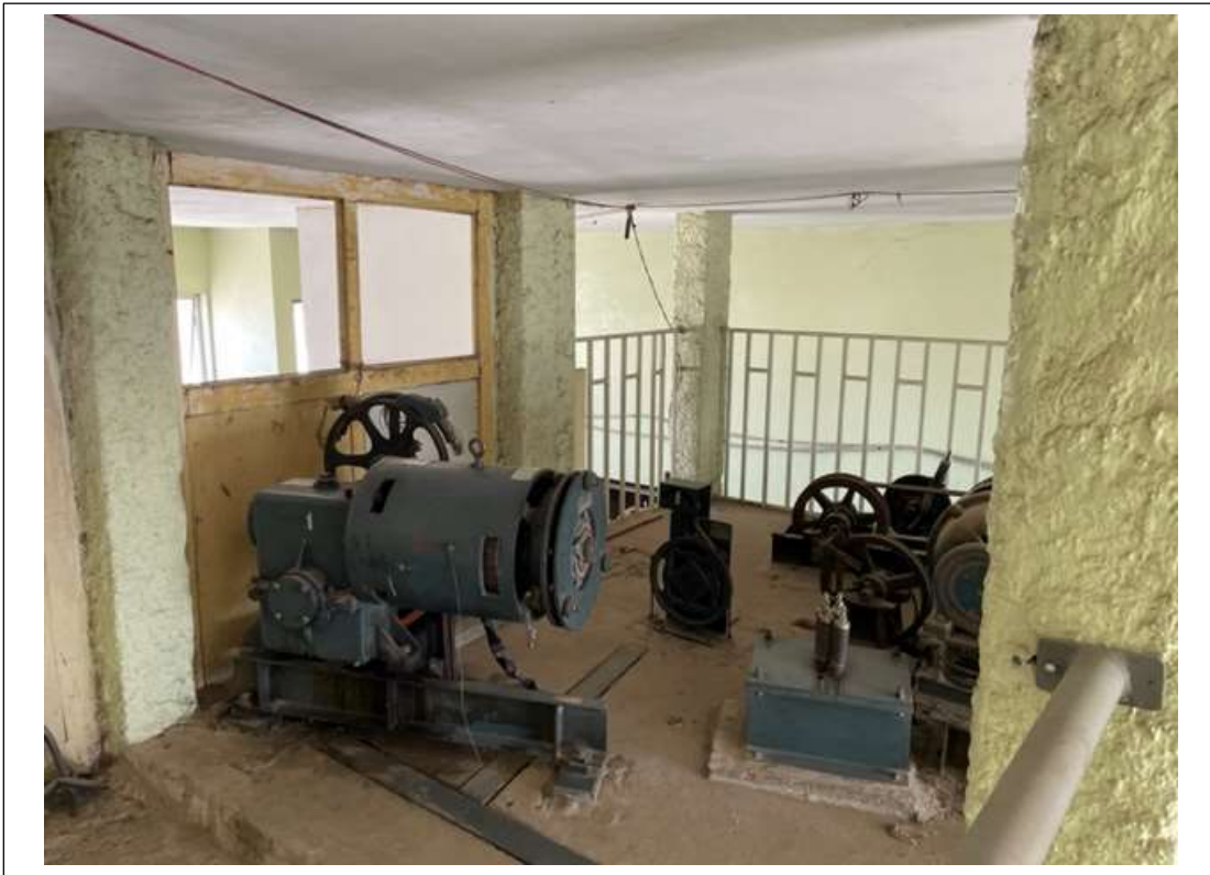
Foto 58: Outra vista da casa de máquinas
