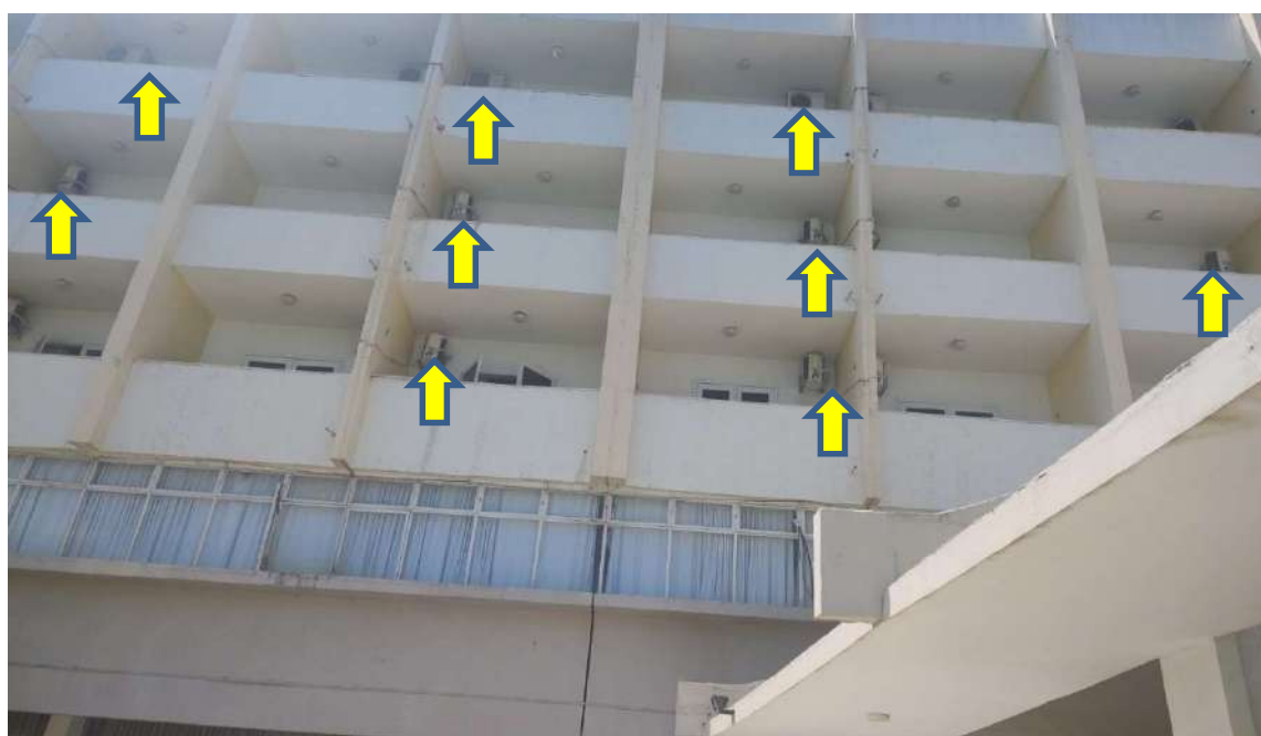
Foto 33: Instalação de novos aparelhos de ar-condicionado em todos os quartos de hóspedes, área gerencial/administrativa e recepção do hotel.
