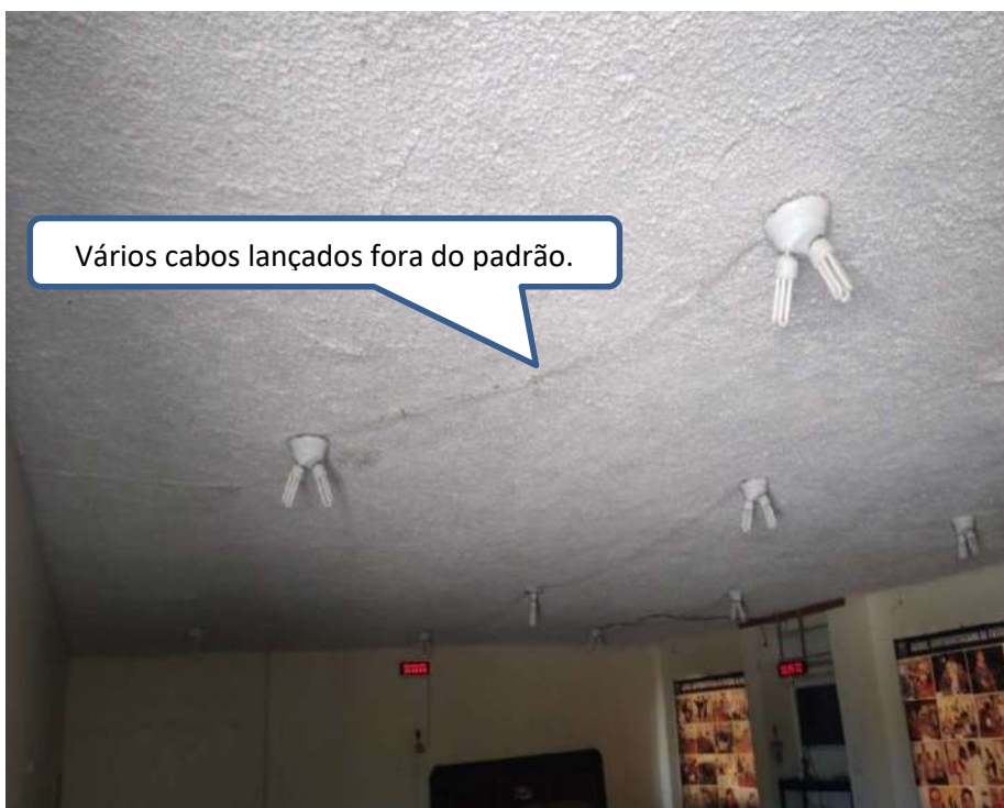
Foto 31: Cabeamento fora de eletroduto, exposto em teto.
