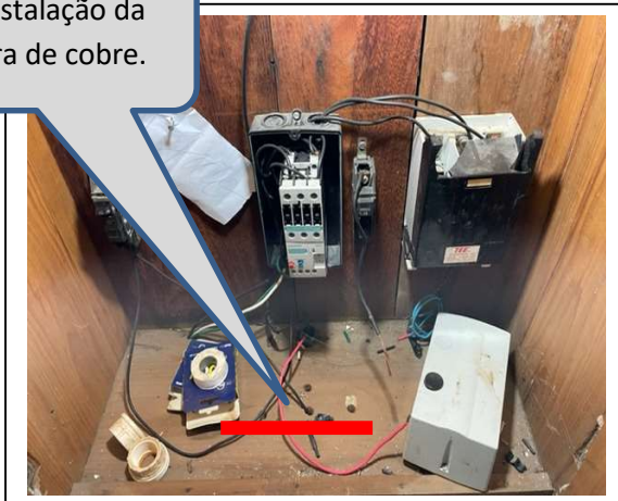
Foto 66 – Ausência de barra de aterramento
