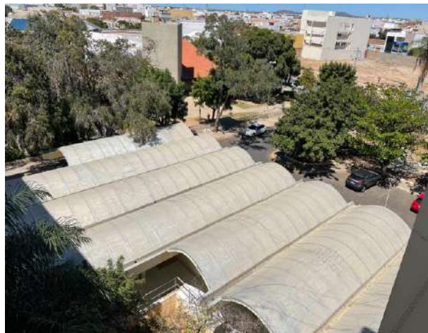
ABÓBADAS DE COBERTURA
