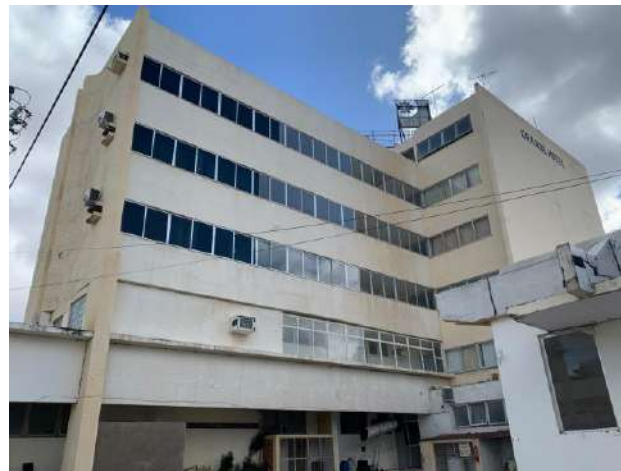
FACHADA DESDE O PÁTIO DE SERVIÇOS
