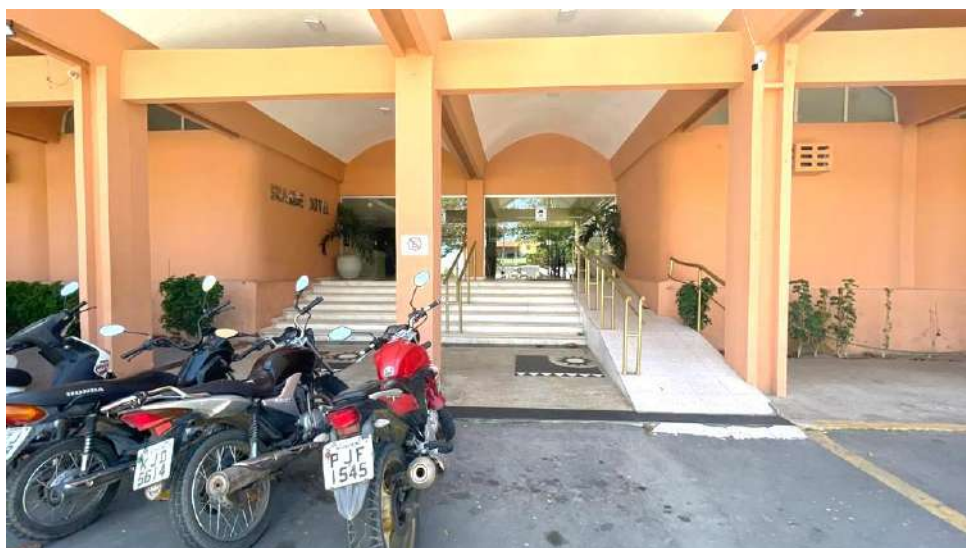
Foto 7 – Escada de Acesso
