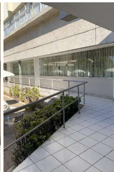
Foto 17 – Vista Externa das Esquadrias do Auditório
