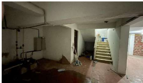
Foto 59 – Vista do hall de acesso a escada
