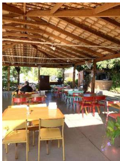
Foto 28 – Telheiro de apoio do restaurante
