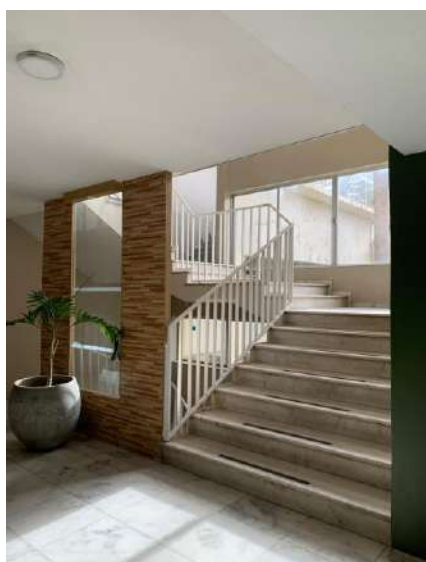
Foto 62 – Escada de acesso ao pavimento
