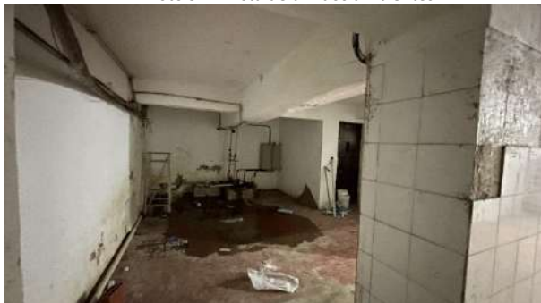
Foto 58 – Vista da chegada do subsolo
