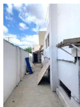
Foto 38 – Imagem do corredor lateral da cozinha e muro da divisa do terreno
